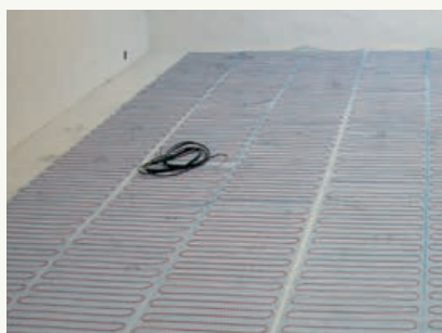
Natte chauffante posée directement sous le revêtement de sol
