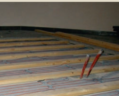
Natte chauffante posée entre couche de poutres
