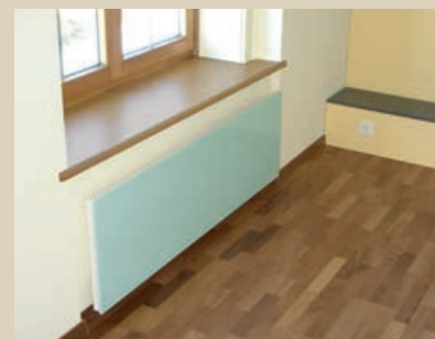
Radiateur en verre sous une tablette de fenêtre
